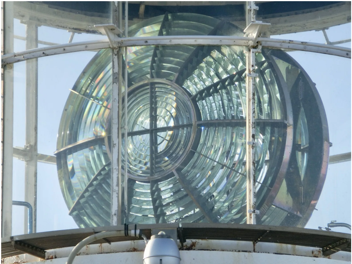
图1 第三级大型菲涅尔透镜在埃里莫角灯塔：由同心棱镜环组成的大型透镜安装在白色框架的灯笼室内
