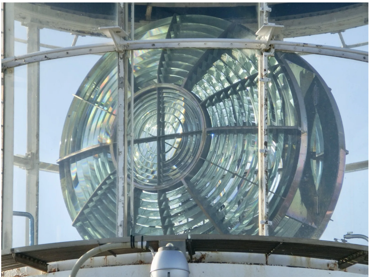
図1 襟裳岬灯台の第3等大型フレネル式レンズ。白い枠組みの灯室の中に、同心円状のプリズムを重ねた大型レンズが据えられている
