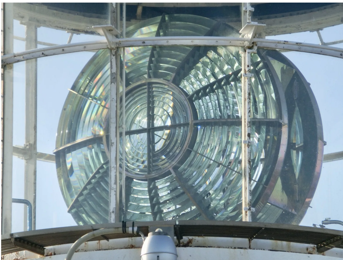
图1 襟裳岬灯塔的三等大型菲涅尔透镜：白色框架灯室内安装着由同心棱镜环组成的大型透镜
